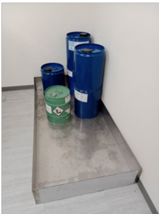
有機溶劑化學品放置地方之大和小防漏盤
